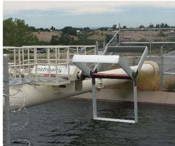
**FIGURE 1, A 25 KW INSTREAM TURBINE INSTALLED IN THE ROZA CANAL, NEAR YAKIMA, WASHINGTON. THE TURBINE IS SHOWN IN THE RAISED, MAINTENANCE POSITION.**
